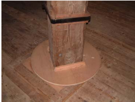
Plaat die aansluit op de koningsspil
