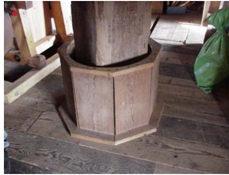
Een ander voorbeeld voor de afscherming van de koningsspil
