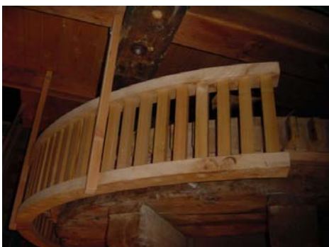
Gedeelte van de afscherming van het spoorwiel ter plaatse van de trapgang
