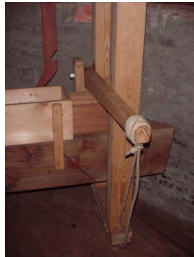
Hangereel voor vastzetten vangbalk met kneppel.
