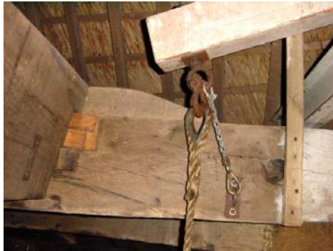
Voorbeeld van het vastzetten van de vangstok
