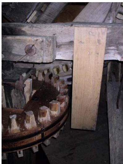
Afscherming ingrijping bonkelaar / schijfloop met bovenwiel.
