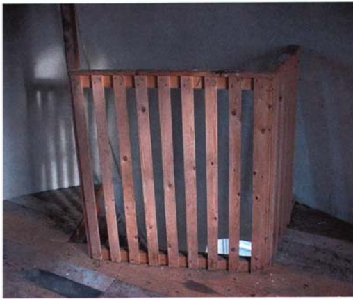
Afscherming van het trapgat. De minimale hoogte van een traphekwerk dient 90 centimeter te zijn. Indien mogelijk is het plaatsen van een extra zelfsluitend draaihekje voor de trap aan te bevelen.
