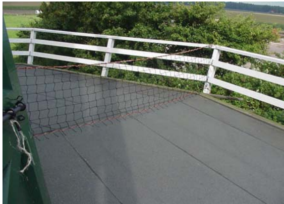
Het is ook mogelijk het gevlucht af te schermen met verplaatsbare hekwerken.
