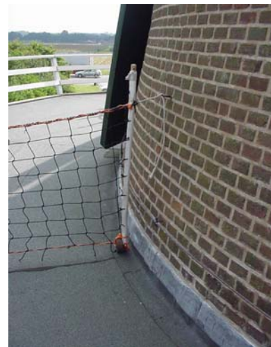
Bevestiging van het net tegen de molenromp met buis om het net te spannen.
