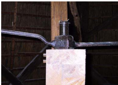
Om te voorkomen dat de schroefdraadspindel er uit gedraaid worden, is het aanbrengen van een borg splitpen noodzakelijk.
