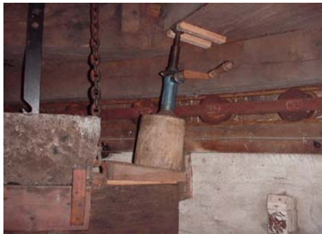
Ook een mogelijkheid is het vastzetten van de vangbalk met een oude potkrik onder tegen het voeghout.
