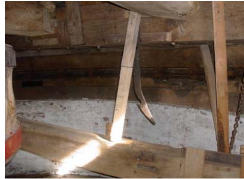
Het vastzetten van de vangbalk met een stiep- of stuthout tussen de vangbalk en het voeghout
