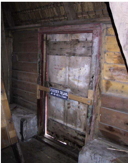
Vergrendel toegangsdeuren naar de stelling bij het gevlucht aan de binnen- of buitenzijde
