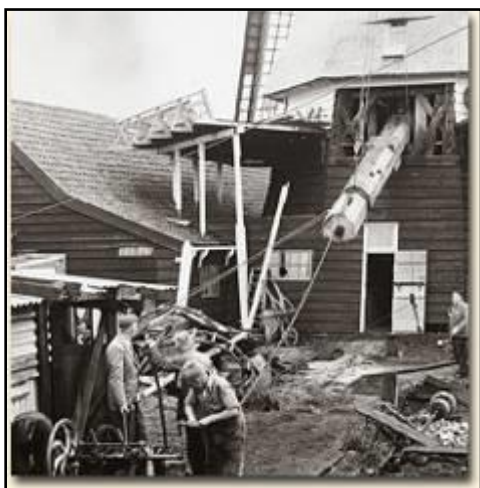
"Even" een nieuwe wentelas installeren (De Ooievaar)
