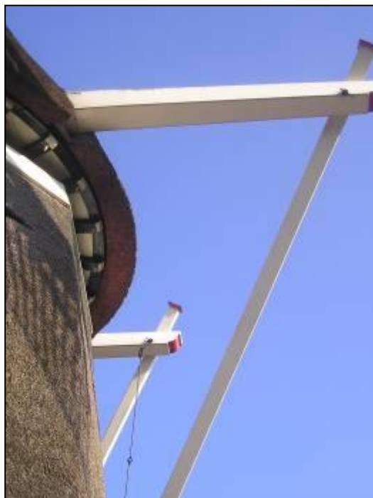
duw en trekwerk door schoren
