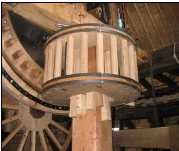
schijfloop in opbouw (afgebrande molen C)
