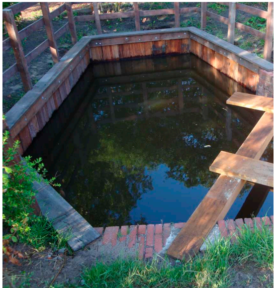
Rechts: Het gevulde bassin, klaar om leeggemalen te worden door de molen, die met de nieuwe roede weer kan draaien en dus de nieuwe vijzel in beweging kan zetten.
