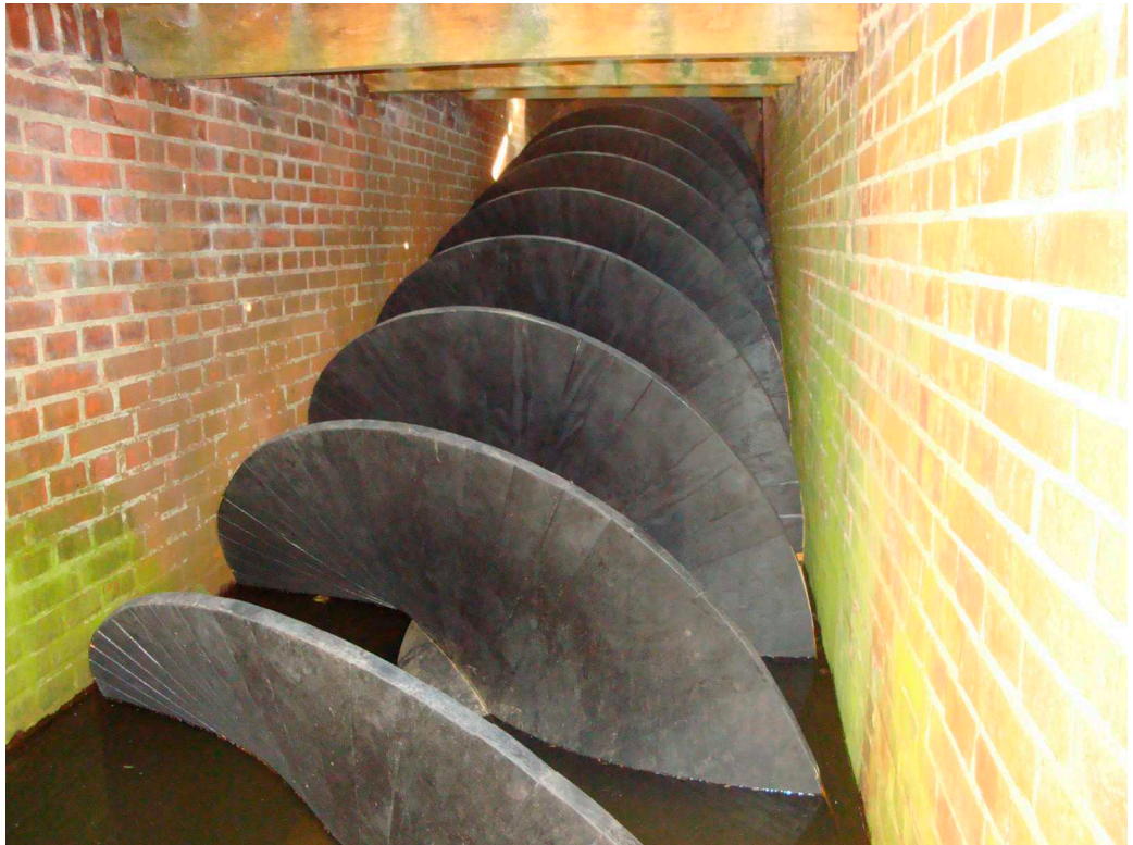
Boven: De nieuwe vijzel op zijn "oude" plek in de vijzelbak.
