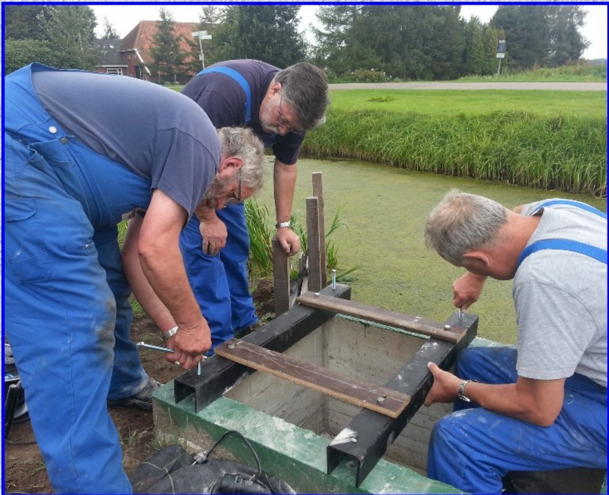
Het afstellen van de U-balken op de kelder
