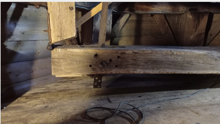
Vangbalk met smeedijzeren scharnier
