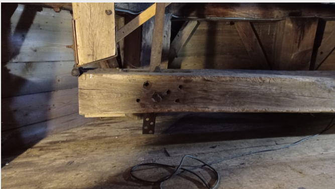
Vangbalk met smeedijzeren scharnier
