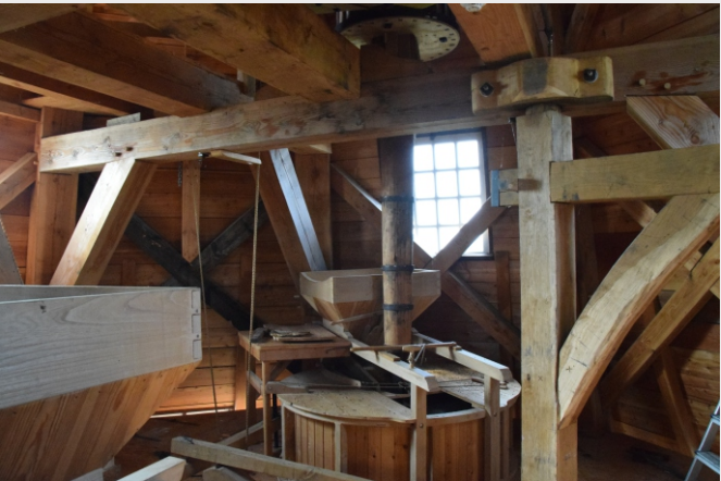
Het westelijk maalkoppel met de steenkraan
