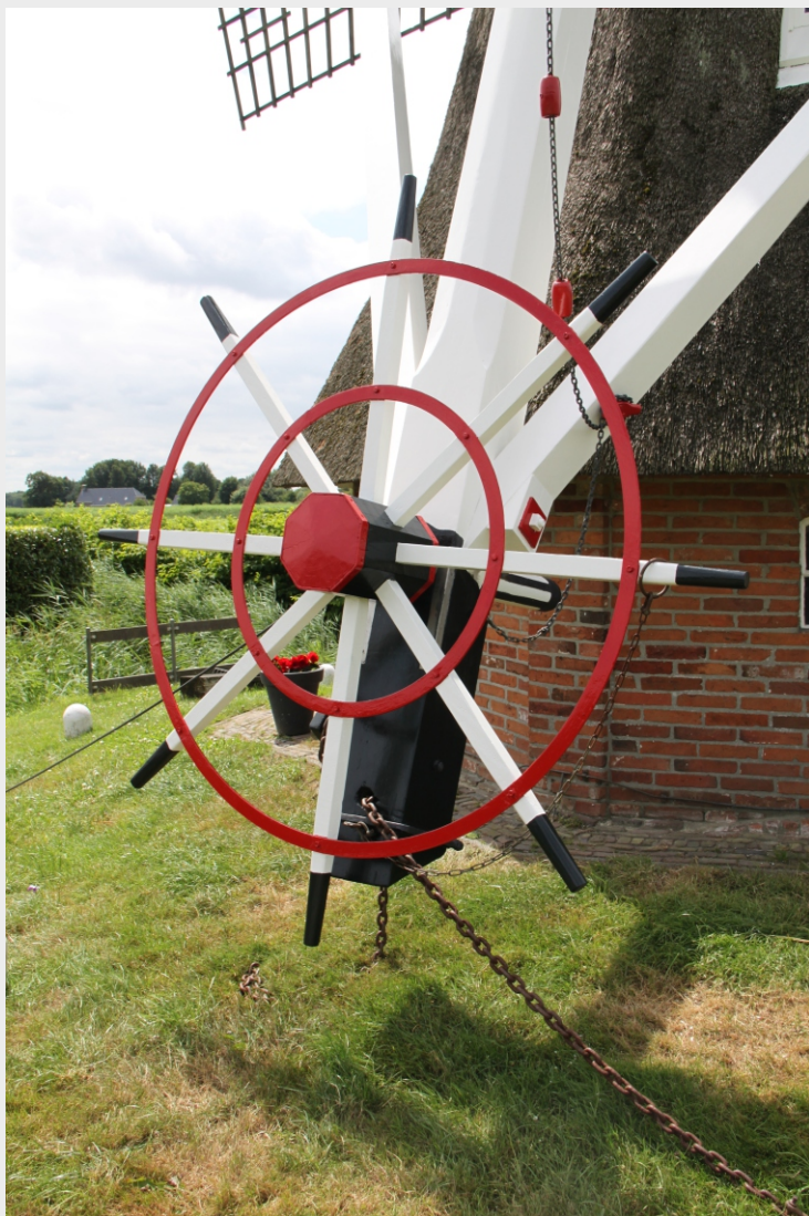
Het kruirad aan de staartbalk (om de molen op de wind te zetten)
