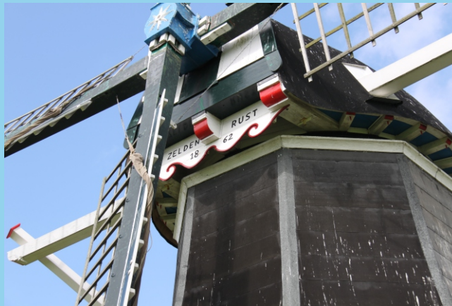
Herstelde kap met nieuwe voeghouten en tempelbalk
