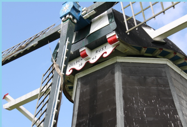
Herstelde kap met nieuwe voeghouten en tempelbalk
