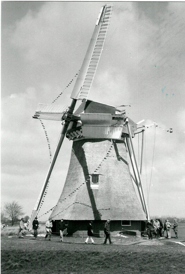
Foto Krimstermolen – Zuidwolde: combineert zelfzwichting met Dekker, met remkleppen.
