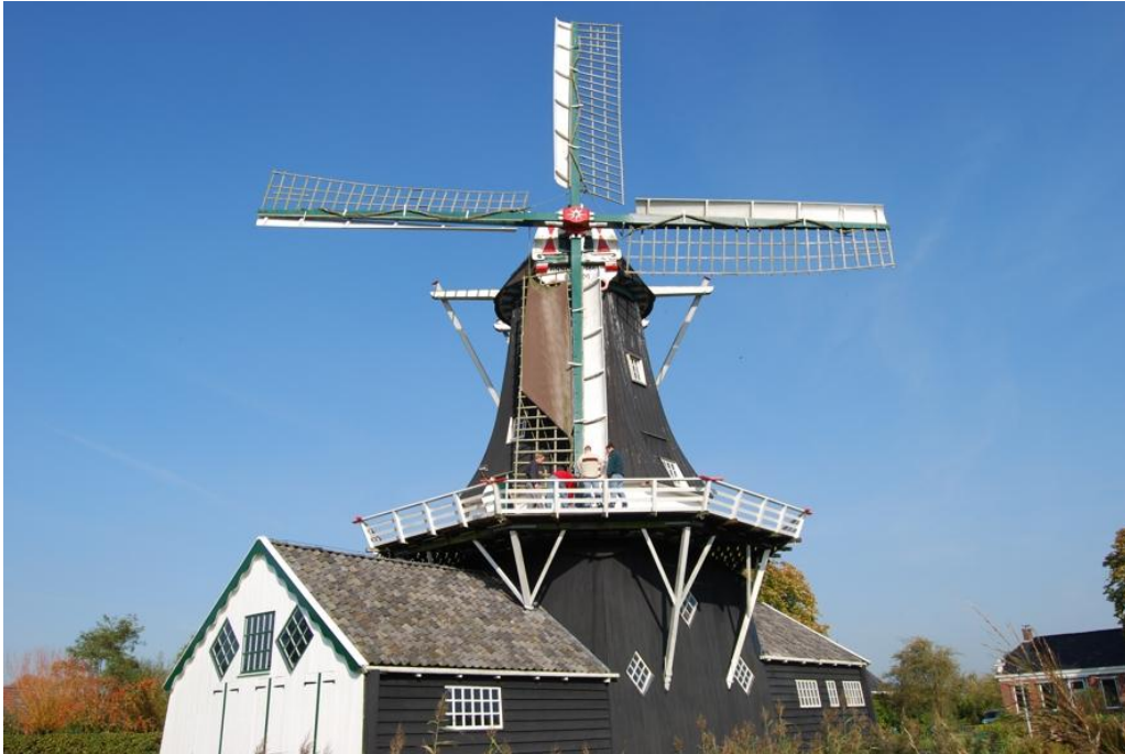
Foto Fram – Woltersum: combineert Fokken met remkleppen
