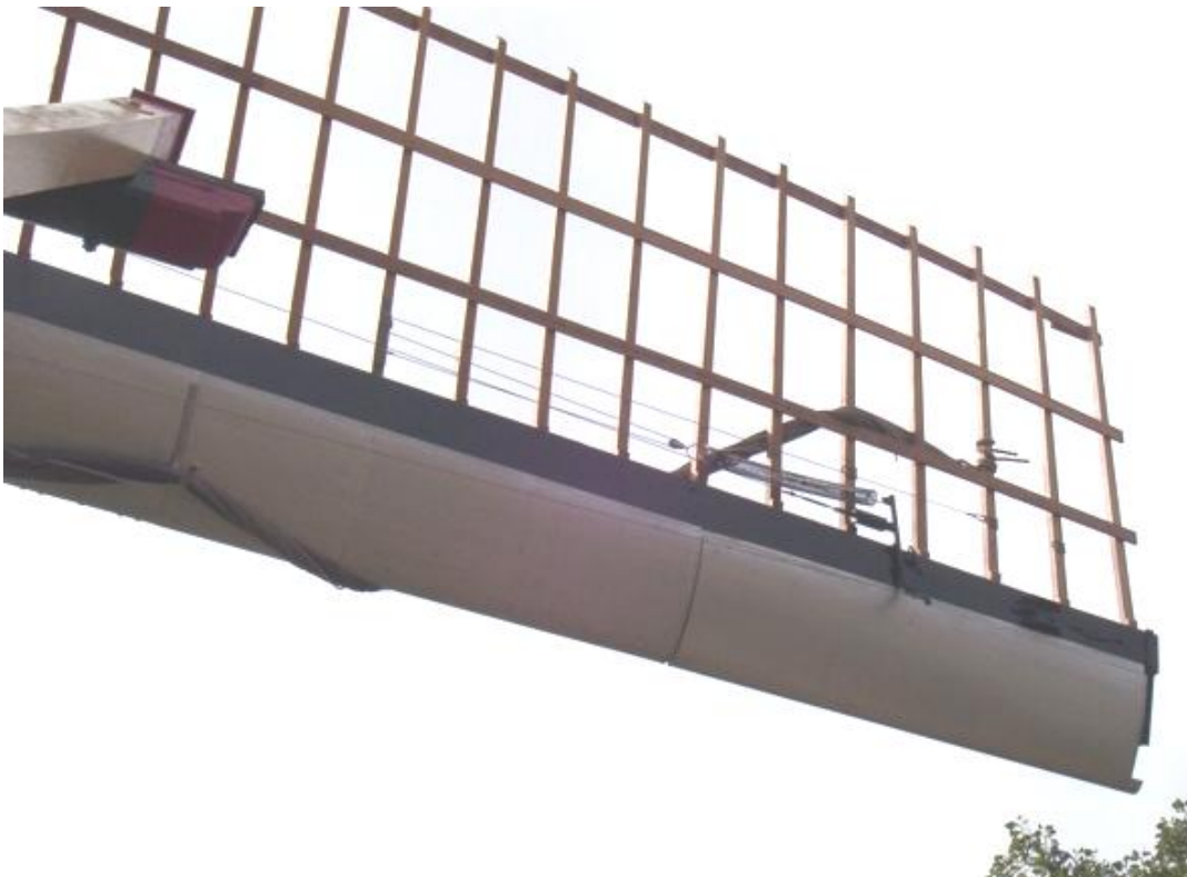
Foto Oosterland (Zld) combineert Van Bussel met centrifugaal veer. Er zijn vele methoden met veer, met of zonder contragewichten.
