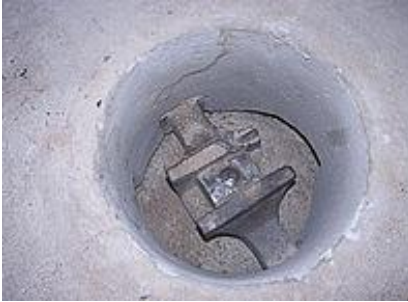
Bovenkant rijn, met middenin het topje vh pennetje dat in de taatspot (links) zit
