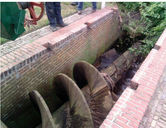
Afbeelding 10: De gangen onderaan de vijzelbalk zijn in de loop van 40 jaar volledig verdwenen.
