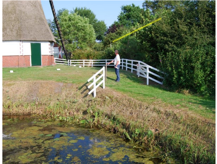
Afbeelding 4: Voorbereidingen aanleg watertoevoer.
