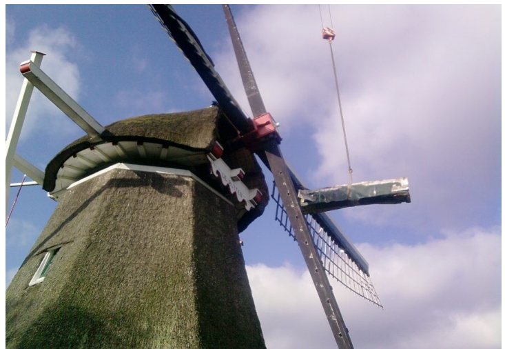
Afbeelding 9: De windpeluw gaat er af: maar goed dat het wiekenkruis is gestut.
