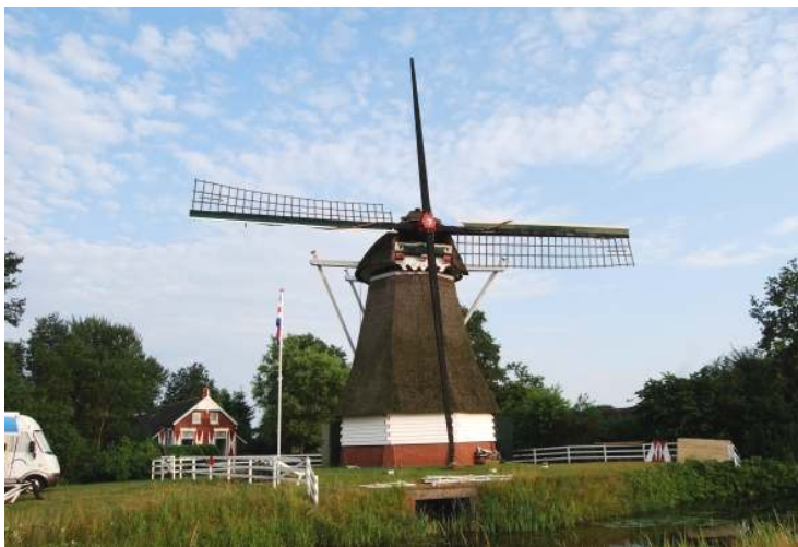
Afbeelding 5: Het wiekenkruis is geborgd en gestut. De buitenroede blijft nog even zitten want dat is de stut.
