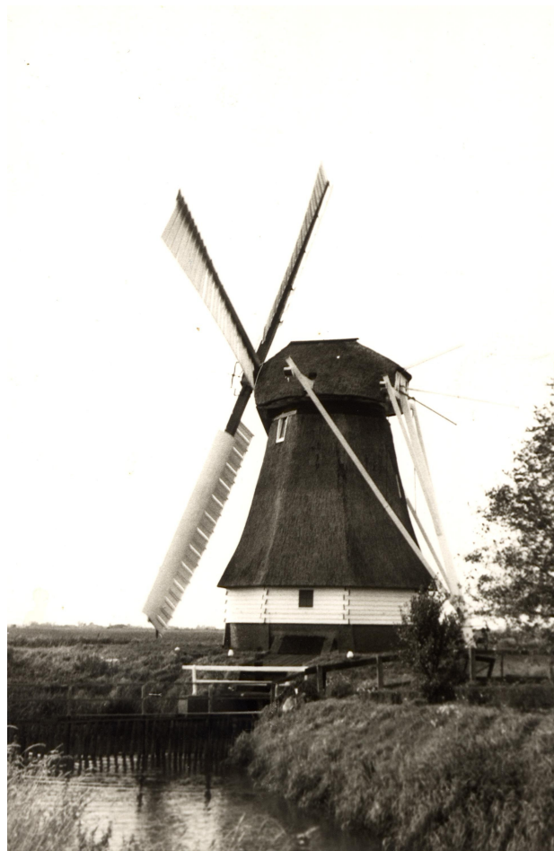
Afbeelding 1: Oorspronkelijke watertoevoer rond 1961. De molen nog uitgerust met zelfzwichting en stevig malend.
