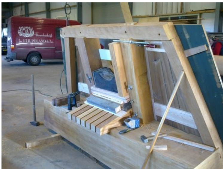
Afbeelding 14: Het voorkeuvelens aan de binnenzijde: in het midden het kussenhout en de halslager, waar straks de zware bovenas met het wiekenkruis in rust.
